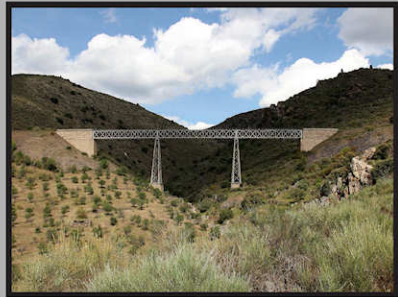
Puente Los Poyos
